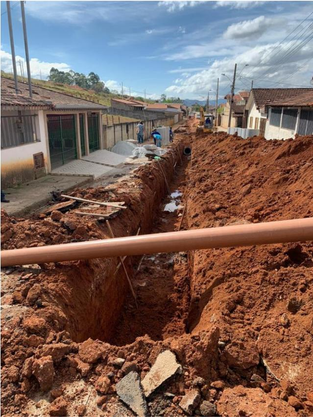
**2 – Escavação de Valas , Drenagem Pluvial**
