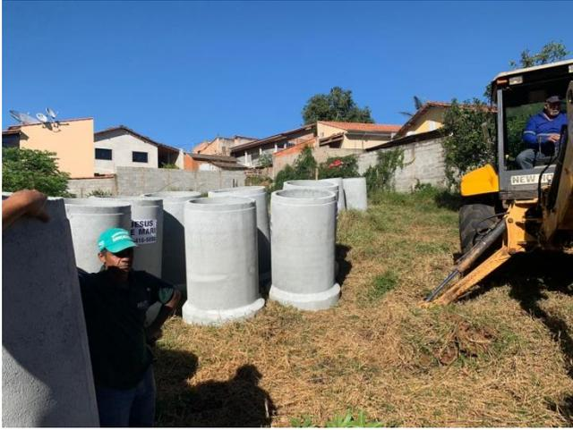
4 Tubos de Concreto para drenagem Pluvial
