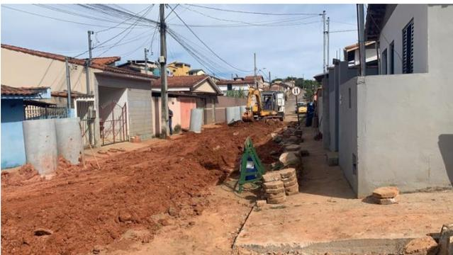
**3 Remoção de Bloquetes, Escavação de Valas, Instalação de Tubulação para drenagem Pluvial**
